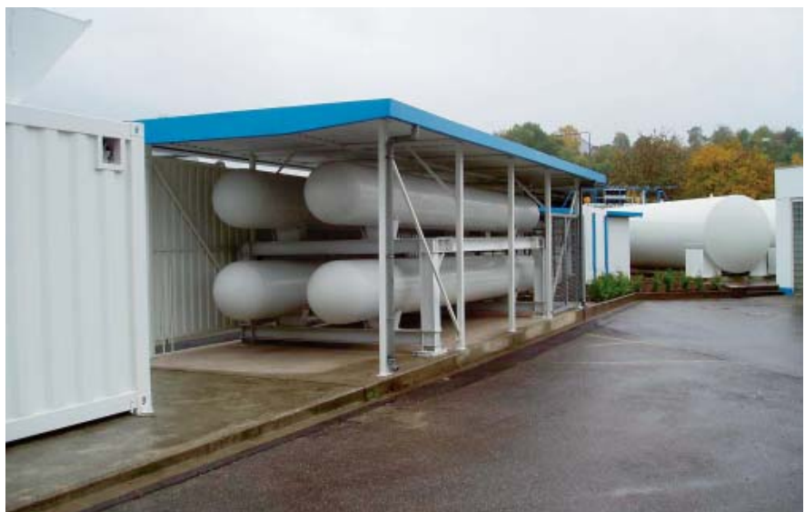
Bild 4 Röhrenspeicher der Erdgastankstelle
